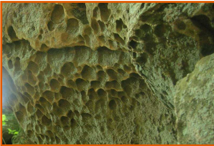
Sandstein mit Wabenverwitterung
