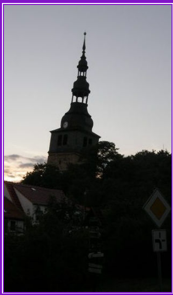
Der schiefe Turm von Bad Frankenhausen
